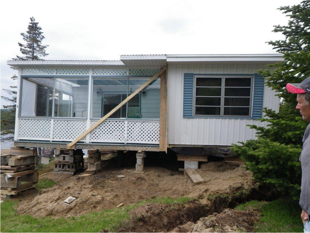
PRISE 2 – VUE LATÉRALE DU CHALET
